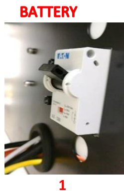
Figura 3 - Panel eléctrico Z.STORE-ED1
