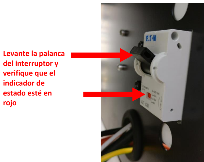
Figura 84 – Levante la palanca del interruptor QB1 para reiniciar M.Store-ED1
