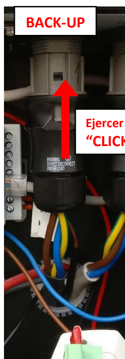
Figura 59 – Inserción del enchufe instalado en la línea "EPS BACK-UP"
