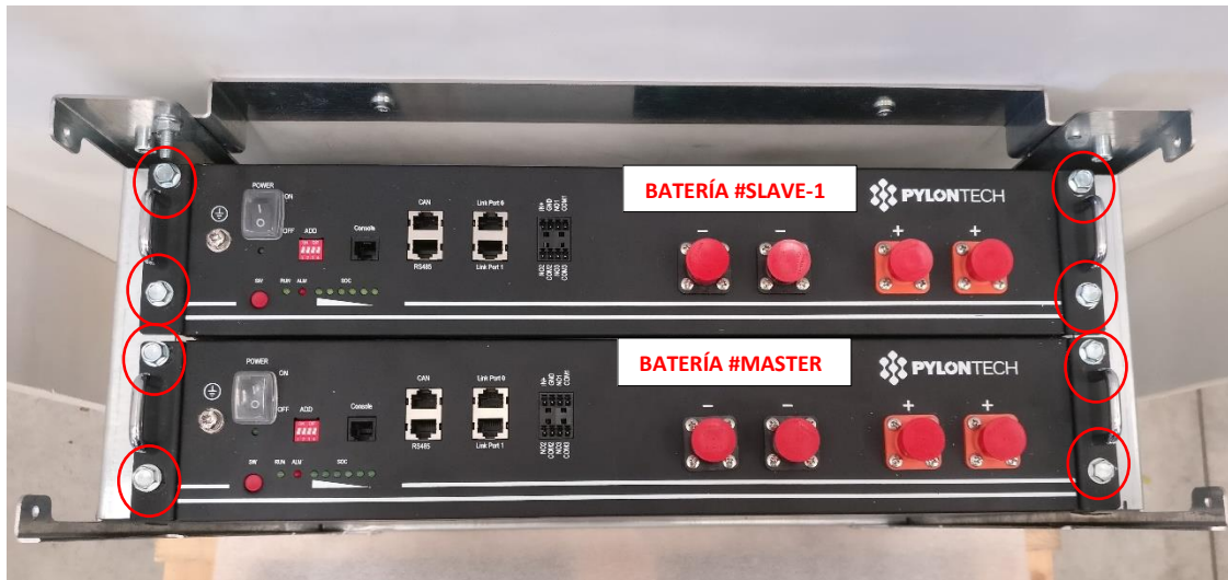
Figura 11 – Fijación de módulos de baterías a la caja de baterías
