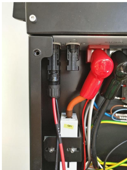
Figura 52 – Conexión de los conectores MC4
