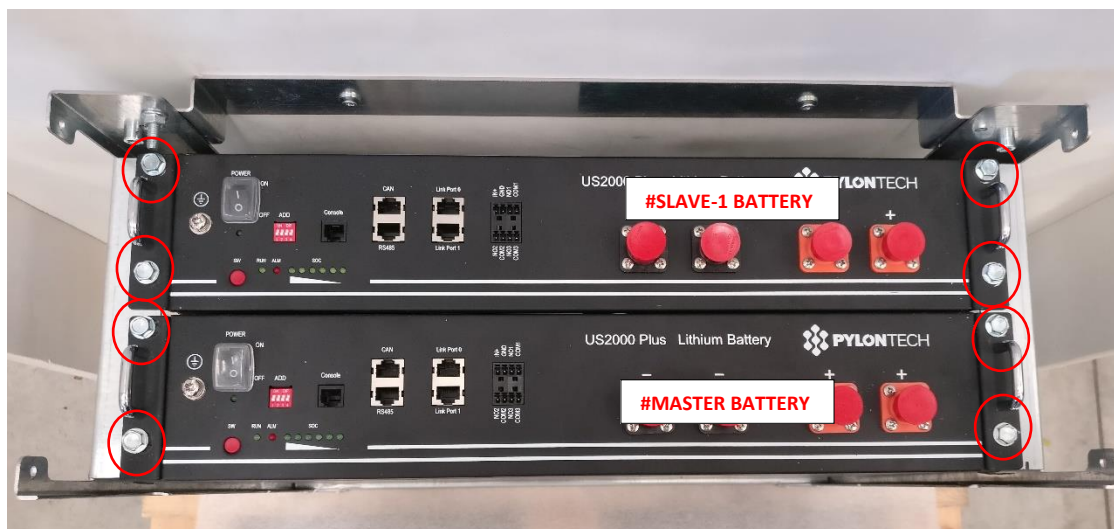
Figura 10 – Fissaggio moduli batteria al box batteria
