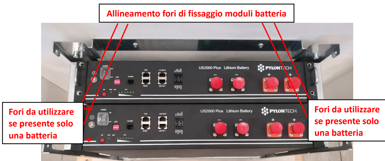
Figura 8 - Alloggiamento moduli batteria (se pervisti 2 moduli dalla dotazione)
