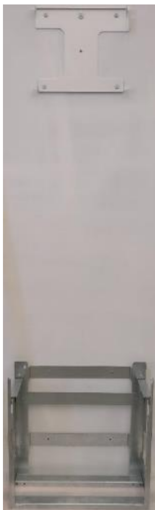
Figura 7 - Soporte inversor y BASE WALL-BOX-Bx fijada a pared
