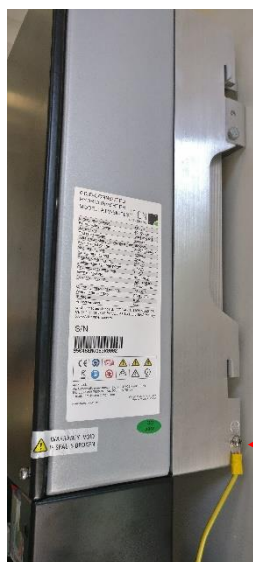
Figura 41 - Conexión entre el nodo de tierra de la máquina y la tierra del disipador de calor
