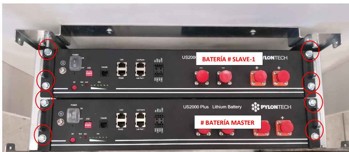
Figura 10 - Fijación de módulos de batería a la caja de batería
