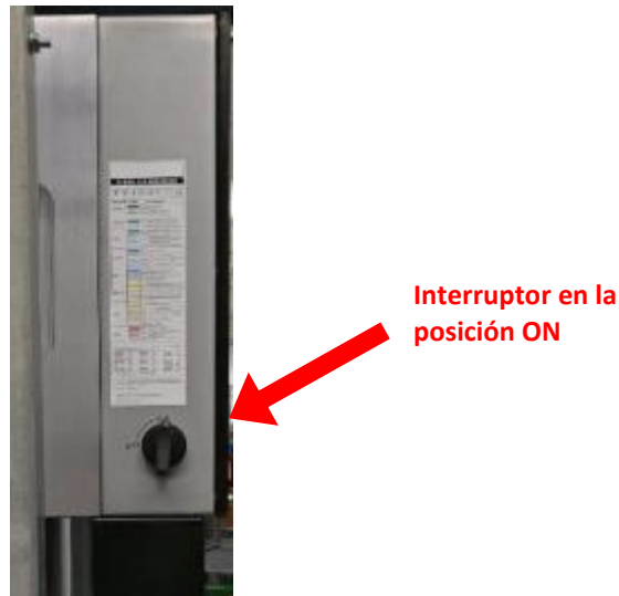
Figura 61 - Encienda el lado izquierdo del elemento ATM-xK-TL en la posición ON
