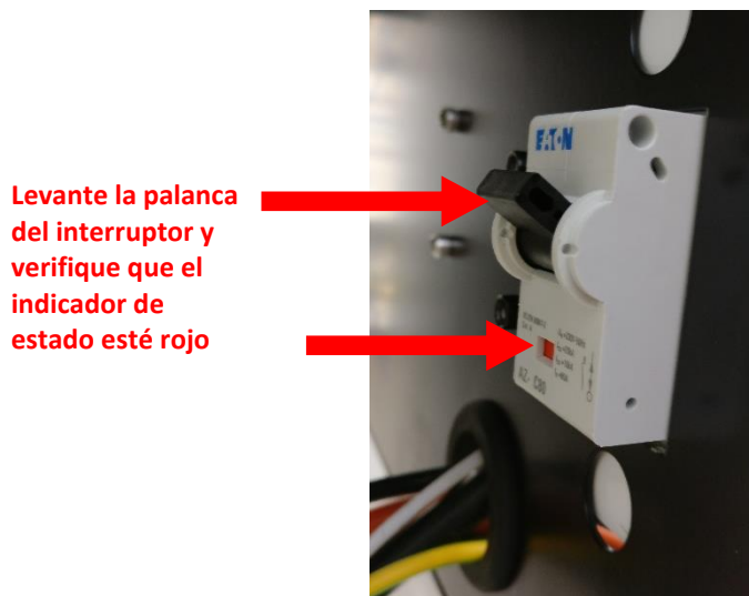
Figura 84 - Levante la palanca del interruptor QB1 para activar el M.Store
