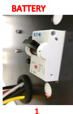
Figura 3 - Panel eléctrico M.STORE-ED1
